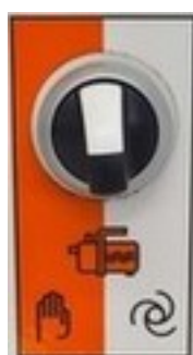
Figura 32: Selettore pompa di aumento di pressione
