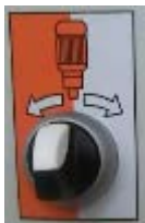
Εικόνα 17: Διακόπτης επιλογής κινητήρα αντλίας
