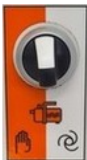
Afbeelding 32: Keuzeschakelaar drukverhogingspomp
