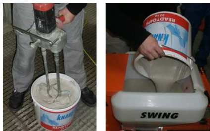
Figura 55: Llene el tambor de material con material
