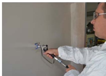
Figura 63: Pulverizarea materialului
