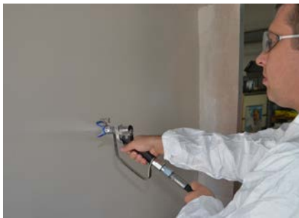
Afbeelding 63: Materiaal opspuiten
