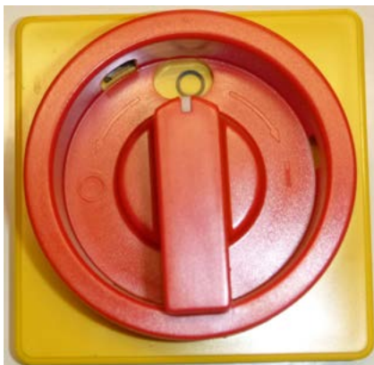
Abb. 69: Hauptschalter auf Stellung „0“
