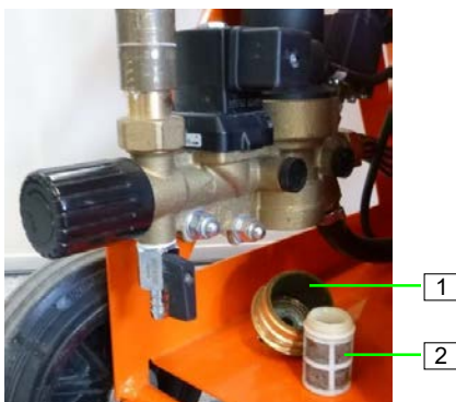
Abb. 128: Schmutzfängersieb im Druckminderer
