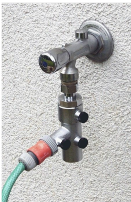
Εικόνα 1: π.χ. διαχωριστής συστημάτων BA295STN της Honeywell
