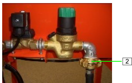
ilustracja 16: Przyłącze wody bez pompy wspomagającej
