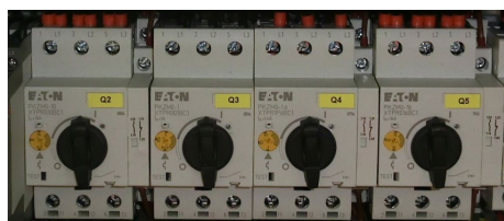
Abb. 1: Motorschutzschalter
