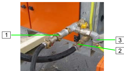
Abb. 41: Anschluss Wasserversorgung
