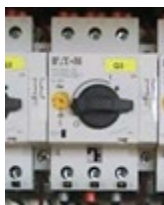
Abb. 28: Motorschutzschalter überprüfen
