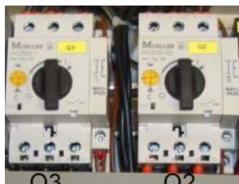
Σχ. 1: Ασφαλειοδιακόπτης κινητήρα ηλεκτρικού πίνακα, αρ. τυχ. 00046174
