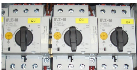
Σχ. 2: Ασφαλειοδιακόπτης κινητήρα ηλεκτρικού πίνακα, αρ. τυχ. 00681407
