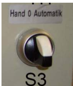
Σχ. 10: Τρόποι λειτουργίας περιστροφικού συμπιεστή
