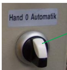
Σχ. 36: Χειροκίνητη λειτουργία – «0» – Αυτόματη λειτουργία
