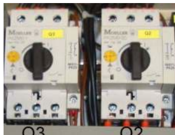
Sl. 1: zaštitna sklopka motora u razvodnom ormaru, br. art. 00046174
