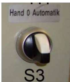
Sl. 10: načini rada rotacijskog kompresora
