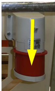
Sl. 58: prekid dovoda struje
