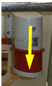
Рис. 50: Прерывание подачи электропитания
