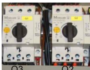
Рис. 1: Защитный автомат двигателя шкафа управления арт. № 00046174
