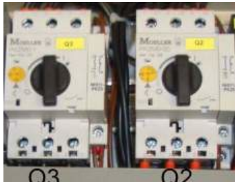
Res. 1: Kontrol kabini motor koruma anahtarı ürün no. 00046174
