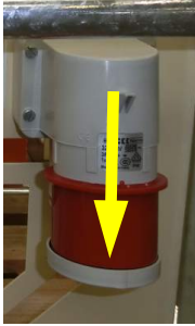
Res. 50: Elektrik beslemesinin kesilmesi
