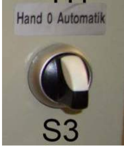
Res. 10: Döner kompresör çalışma türleri
