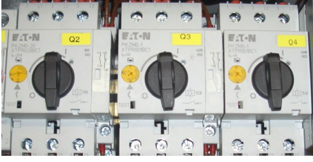
Res. 2: Kontrol kabini motor koruma anahtarı ürün no. 00681407
