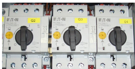
Illustration 2 : Disjoncteur-protecteur de l'armoire de commande n° d'art. 00681407
