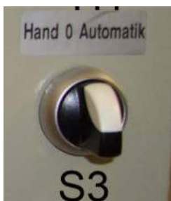
Illustration 10 : Modes de fonctionnement du compresseur rotatif
