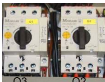
Illustration 1 : Disjoncteur-protecteur de l'armoire de commande n° d'art. 00046174
