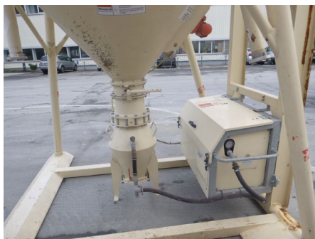
Illustration 14 : Pose du SILOJET
