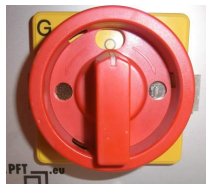
Fig. 57: Commutatore-invertitore principale
