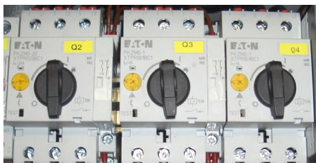
Fig. 2: Salvamotore quadro elettrico numero articolo 00681407
