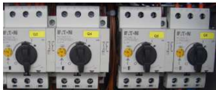
Figura 4: Întreprător de protecție a motorului
