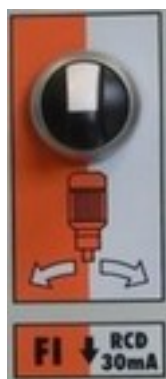
Afbeelding 21: Selectieschakelaar pompmotor
