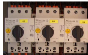
صورة 1 مفتاح قطع الدائرة عن الموتور
