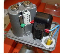
صورة 49: مفتاح أمان ضغط الهواء
