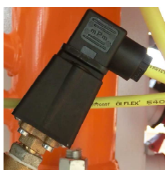
Fig. 91: Interruptor de presión del agua
