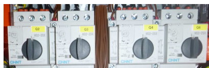
Рис. 1: Защитный выключатель электродвигателя
