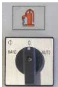
Рис. 15: Режимы работы насоса для повышения давления
