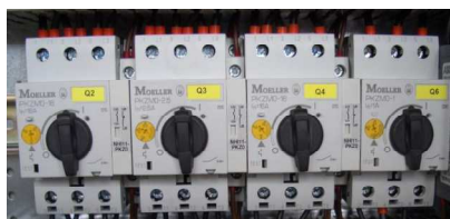
Рис. 1: Автомат электродвигателя
