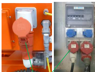
Fig. 26: Allacciamento elettrico 230V FU
