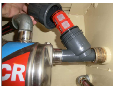
Fig. 88: Filtro anti impurità
