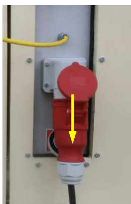
Fig. 92: Rimozione del cavo di collegamento
