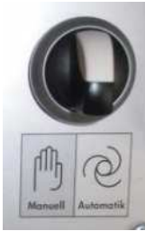
Abb. 54: Hand „0“ Automatik-Schalter
