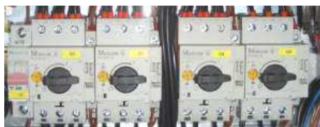
图 1：电机保护开关
