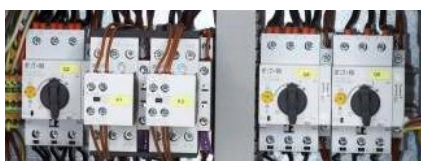
Figure 4 : Disjoncteur-protecteur
