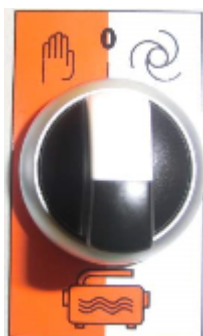
Figure 19 : Sélecteur de la pompe d'augmentation de pression
