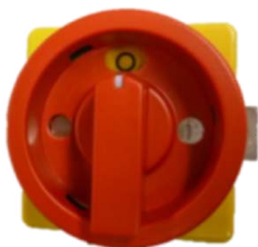
Slika 64: Glavno preklopno stikalo obrnite na položaj "0".
