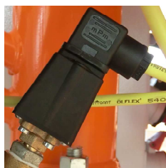
Kuva 101: Veden painekeytkin
