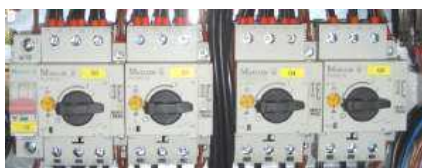
Kuva 1: Moottorinsuojakytkin
