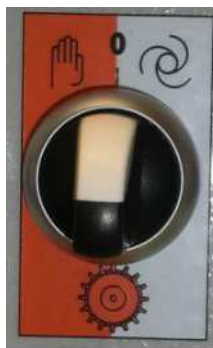
Kuva 12: Siipipyörän käyttötavat
