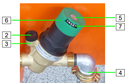
Фигура 29: Настройка на редуктора на налягане
