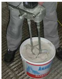
Fig. 28: Agitar el material
