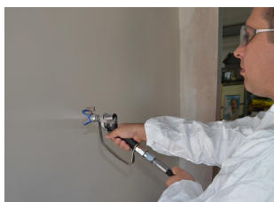
Fig. 47: Proyectar el material
