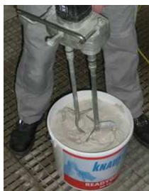
Фиг. 27: Разбъркване на материала
