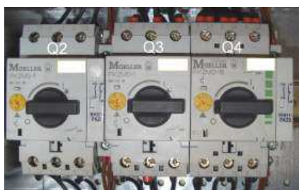
Рис. 1. Защитный выключатель электродвигателя
