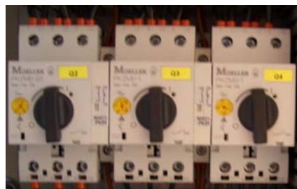
Afbeelding 4: Motorbeveiligingsschakelaar
