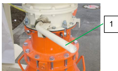
Illustration 36 : Fermer le clapet de la sortie du silo
