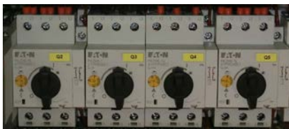
Abb. 4: Motorschutzschalter
