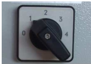
图 10: 选择开关“水泵”位
