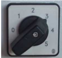
图 12：选择开关“泵电机”位
