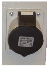
图 30: 泵电机接口
