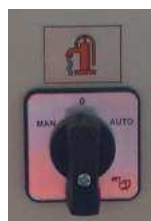
Fig. 19: Modos de funcionamento da bomba de pressurização
