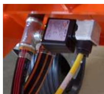
Fig. 99: Presostato de aire
