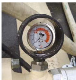
Afb. 54: Morteldrukmanometer
