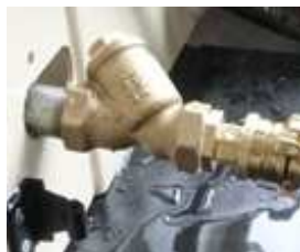
85. att. Netīrumu uztveršanas siets
