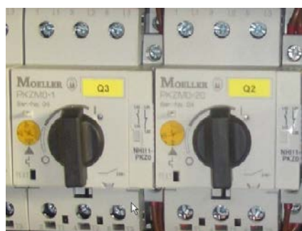
slika 4: Zaštitni prekidač motora
