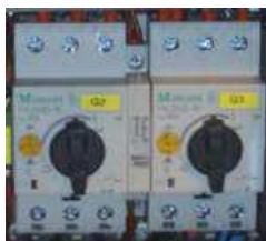
Sl. 1 zaštitna sklopka motora
