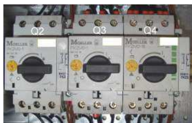
Рис. 1 Защитный выключатель электродвигателя
