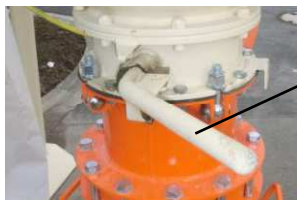
Рис. 34: Закрыть выпускной клапан на силосе
