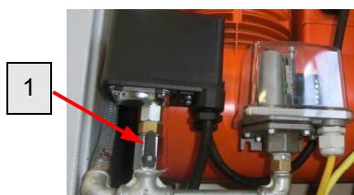
Abb. 58: Kugelhahn Druckabschaltung
