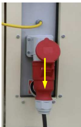
Abb. 89: Anschlusskabel entfernen
