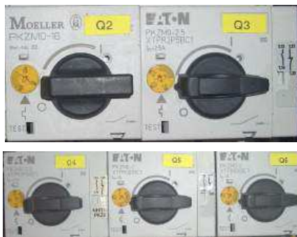
Abb. 1: Motorschutzschalter
