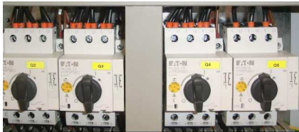
图 1: 电机保护开关
